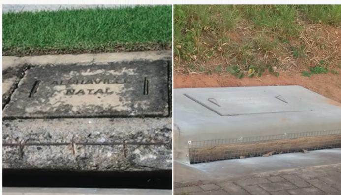
Ferragens das bocas de lobo em processo de corrosão e sem proteção. Foram recuperadas 180 bocas de lobo e colocadas telas de proteção em 215, para evitar que sujeiras caiam na rede de drenagem.
