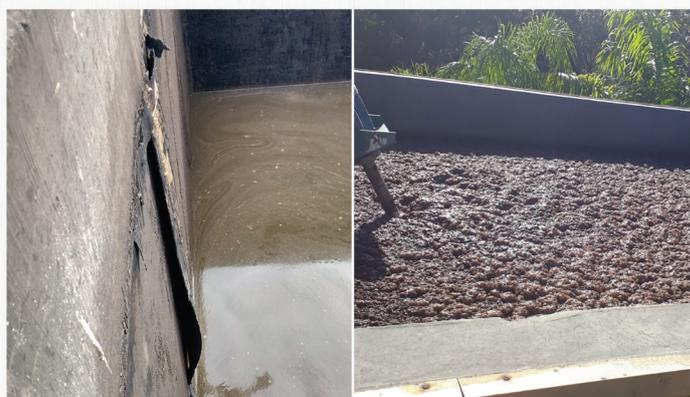
Tanque estava apresentando infiltrações causadas pelo deslocamento da manta. Foi realizada nova impermeabilização com aplicação de produto de membrana de epóxi moldada in loco, ideal para áreas sujeitas ao contato com agentes químicos agressivos.
