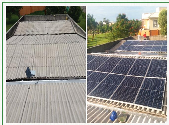
O sistema é composto basicamente por painéis fotovoltaicos, inversor de corrente e um medidor bidirecional. Ele é baseado na conversão direta da radiação do sol em eletricidade, sem partes móveis, sem ruídos, com baixa manutenção e de simples e rápida instalação, proporcionando benefícios socioeconômicos, ambientais e estratégicos, cada vez mais relevantes à nossa sociedade.
