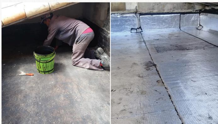
Ocorria infiltração na laje, devido à manta ter deslocado por falha executiva. Foi realizada nova impermeabilização com manta asfáltica de 3mm.
