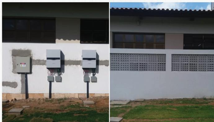
A obra possibilita a proteção dos inversores contra as intempéries. O papel principal é basicamente inverter a energia elétrica gerada pelos painéis de Corrente Contínua (CC) para Corrente Alternada (CA). E o papel secundário é garantir a segurança do sistema e medir a energia produzida pelos painéis solares.
