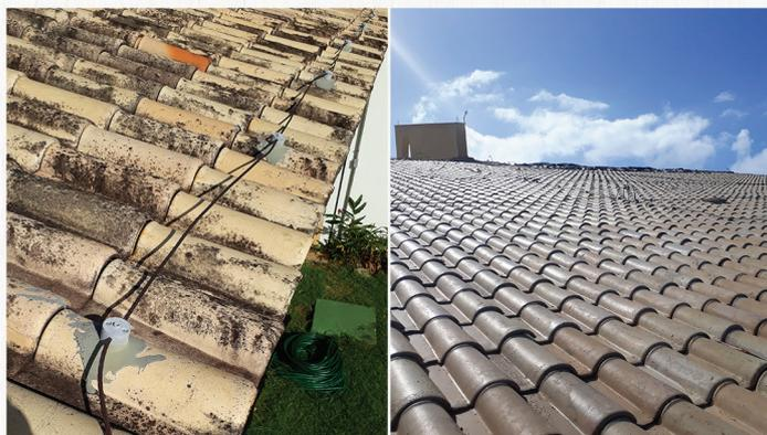
Cobertura apresentava infiltrações, telhas quebradas e deterioradas. Foi realizada a retirada das telhas, lavagem e retelamento com substituição das que apresentavam falha no seu desempenho.
